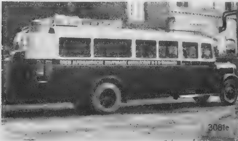
Bild 5. Umgebauter Autobus mit Saurer-Motor BN (Imbert-Gaserzeuger)
